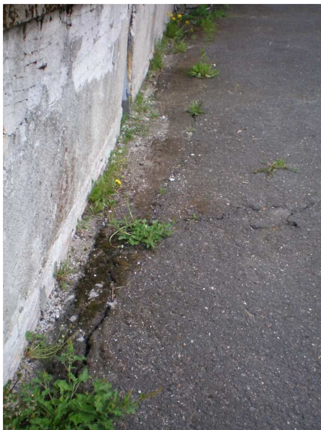
ABSENCE ODVODU POVRCHOVÉ VODY
