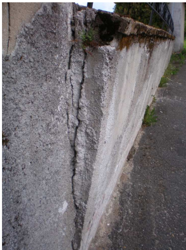
SPÁRA NAPOJENÍ NA VSTUPNÍ BRÁNU
