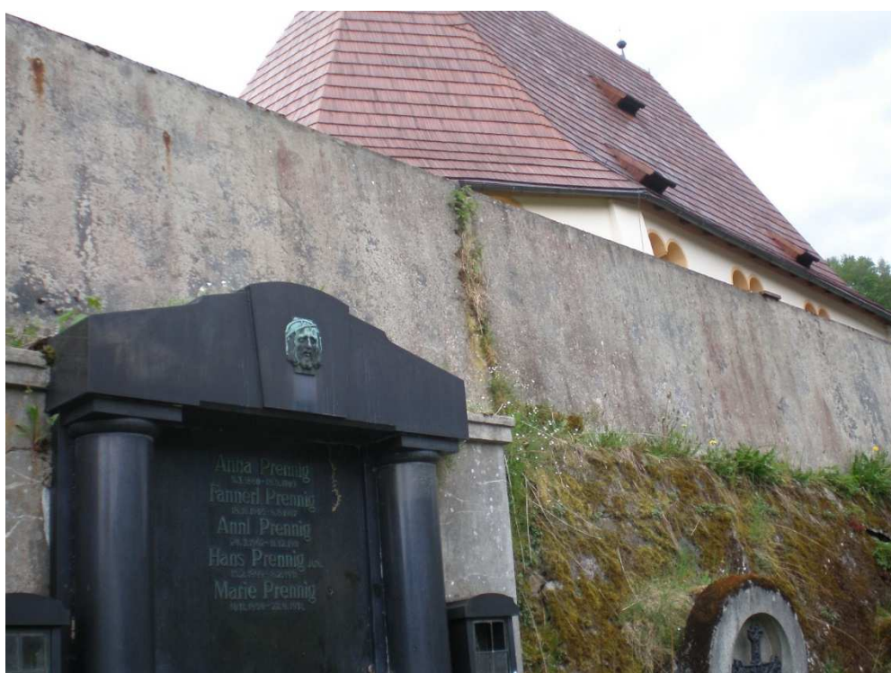
HORNÍ NADEZDÍVKA (ZÁBRADLÍ) – cementová omítka
