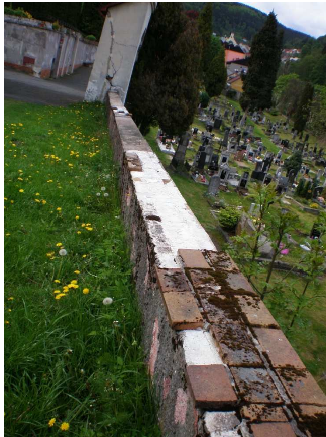
HORNÍ ČÁST (ZÁBRADLÍ) doplnit ураžené části nadezdívky NEÚPLNÉ KRYTÍ VRCHNÍ PLOCHY ZDI
