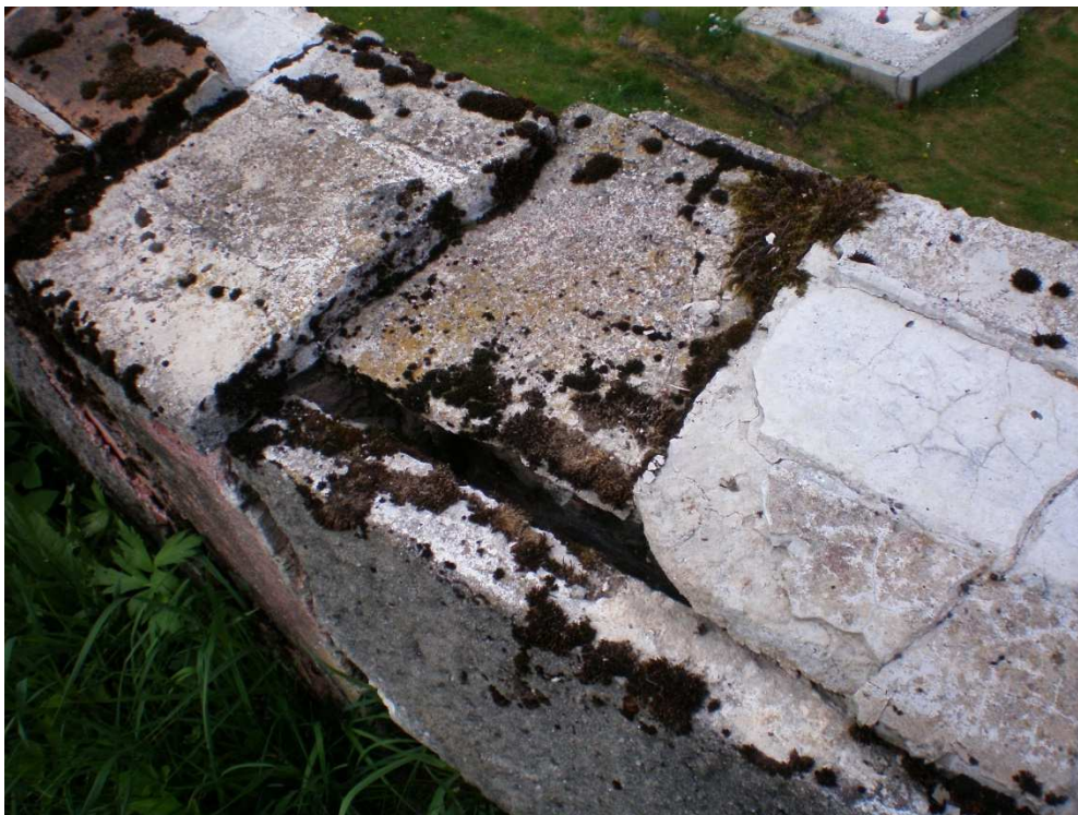
DETAIL HORNÍ ČÁSTI ZDI (nadezdívky zábradlí) degradovaná část omítky se po vrstvách odděluje
