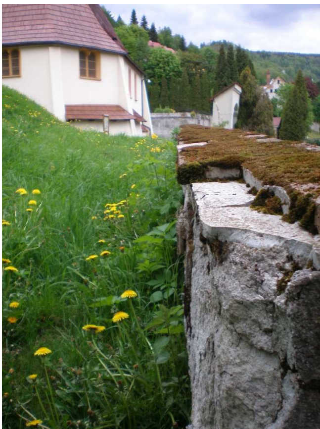
HORNÍ ČÁST (ZÁBRADLÍ) doplnit ураžené části nadezdívky NEÚPLNÉ KRYTÍ VRCHNÍ PLOCHY ZDI
