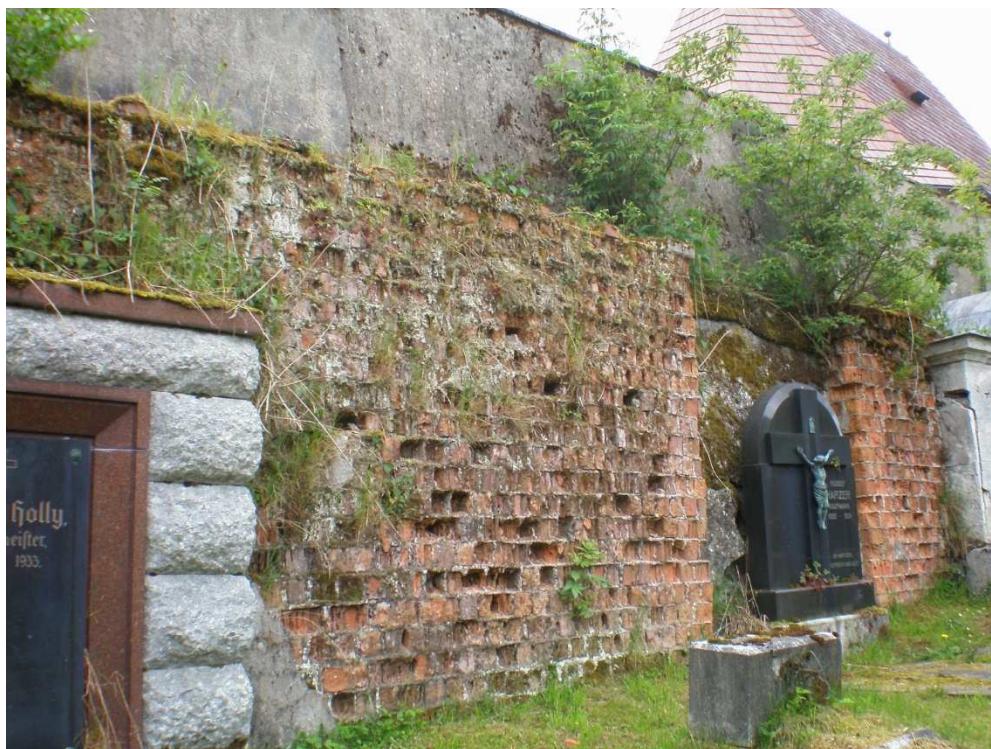
DEGRADOVANÁ CÍHELNÁ PŘIZDÍVKA (vyzděná dodatečně mezi náhrobní kameny, rozměr cca 6,00 x 2,50 m, plocha 15,00 m 2 ). Přizdívku ponechat, přezdíť uvolněné cihly, celou plochu přetáhnout a vyrovnat cementovou omítkou s vloženou armovací sítí (např. rabicové pletivo, oko 16x16 mm).
